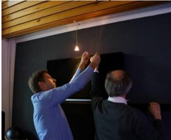
Nach dem die provisorische Deckenhalterung saß, konnte mit der Montage der Leinwand begonnen werden. Wie bei jeder Rahmenleinwand müssen die vier Seitenprofile mit Winkeln verbunden werden. Wichtig (und häufiger Schwachpunkt) sind die Eckverbindungen der Winkel, sie sind oft zu schwach und verbiegen sich leicht oder brechen.
